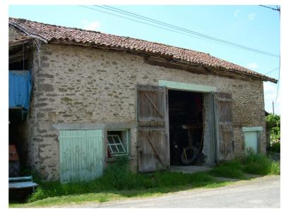
Grange à étable. Celle-ci est maçonnée en petits moellons de granite non dégrossis, disposés en appareils irréguliers et renforcés par des chaînages d'angle en pierre de moyen appareil non taillés. Les portes de la grange et de l'étable sont composées d'un linteau de bois, d'une assise en dalle de granite et de piédroits e pierre.
